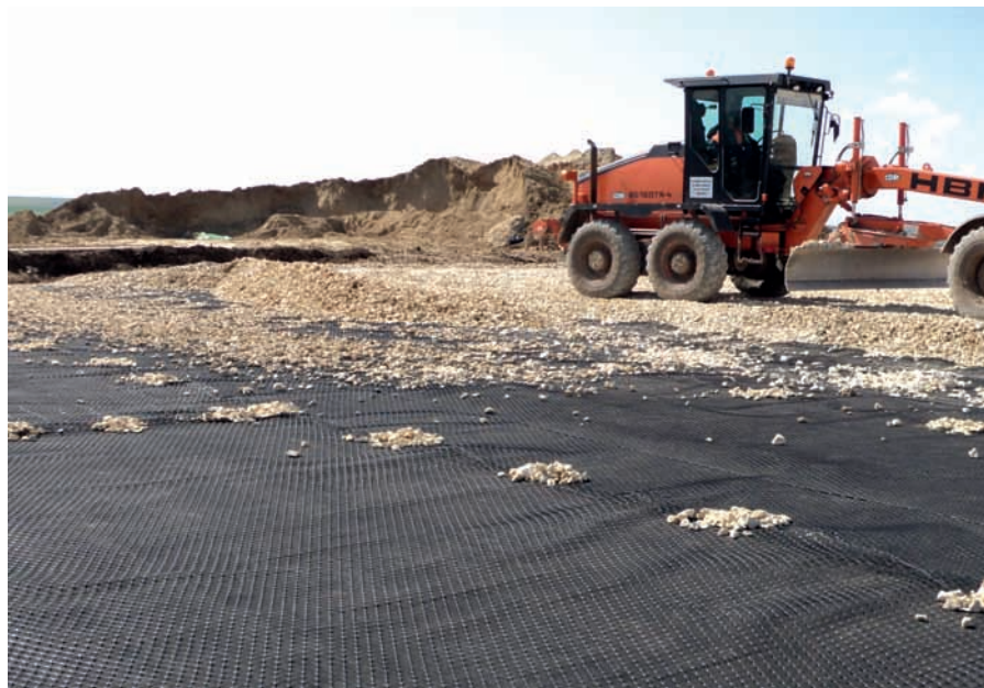
Geogrila TriAx™ este utilizata pentru crearea unui strat mecanic de stabilizare, Parcul Eolian Fantanele, Romania.
