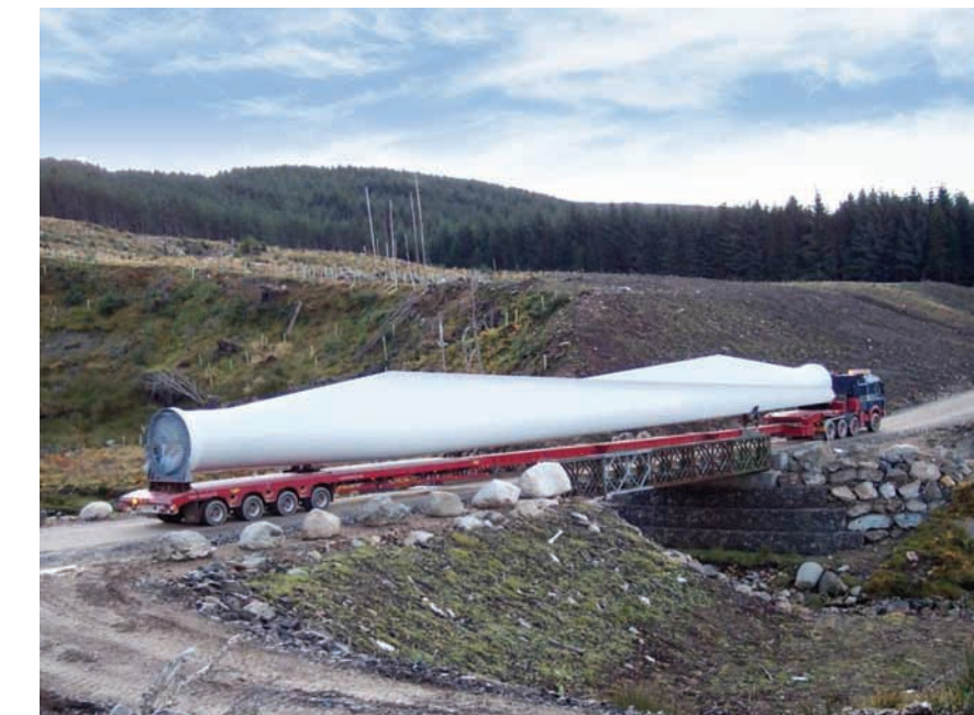
Sistemele de structuri de sprijin Tensartech permit construirea rapidă a culeelor de pod și zidurilor de sprijin. (Fotografie obtinuta prin amabilitatea Comisiei de Silvicultura, Scoția).
