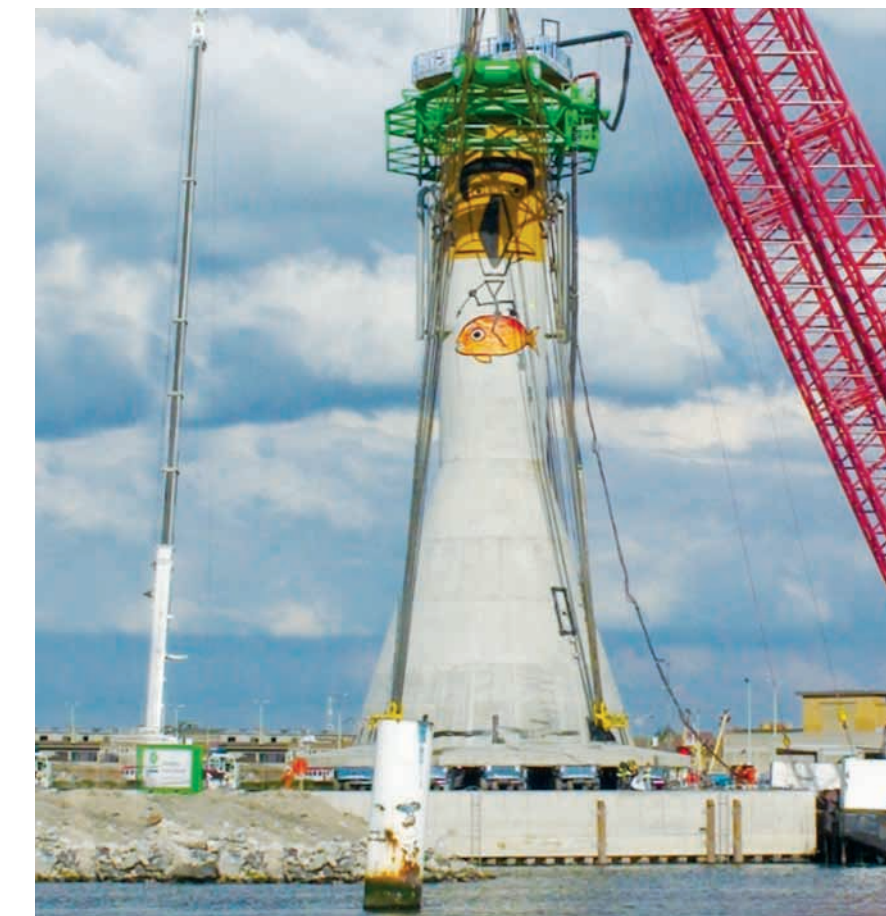
La constructia de parcuri eoliene sunt necesare platforme stabile de lucru. (Fotografie prin bunavointa d-lui Luc Van Braekel).
