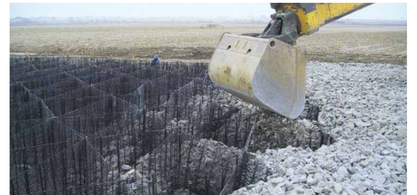
3. Umplerea mecanică a celulelor se va face cu grijă și nu necesită compactare.
