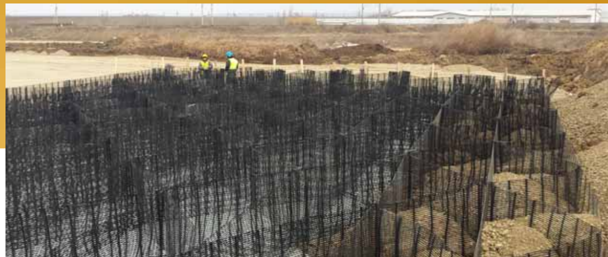
Aplicatie cu Sistem TensarTech® Stratum® pentru stabilizarea si drenajul bazei unui terasament (Centura Tecuci, Romania).
