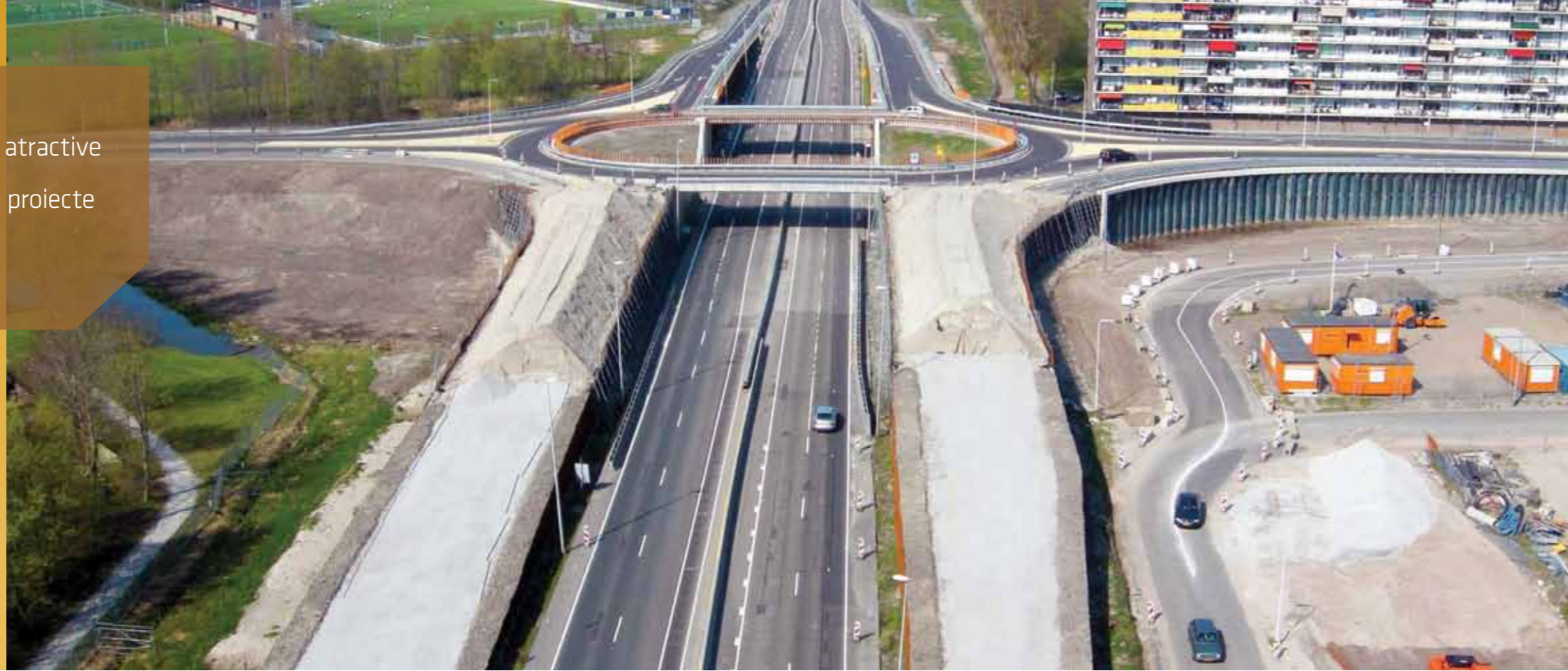
Sistemul TensarTech® Stratum® oferă suport fundamental rigid în controlul tasărilor diferențiate (autostrada A7, Olanda).
