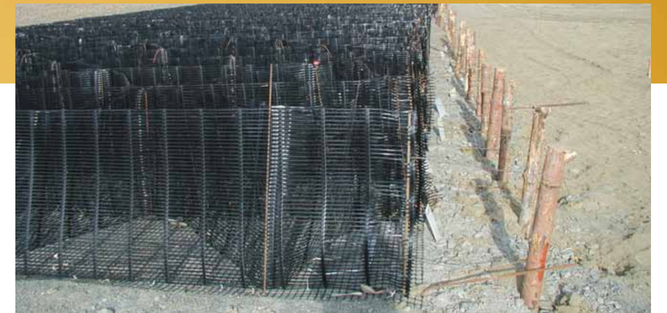
2. Asamblarea rapidă în teren a sistemului TensarTech® Stratum®.
