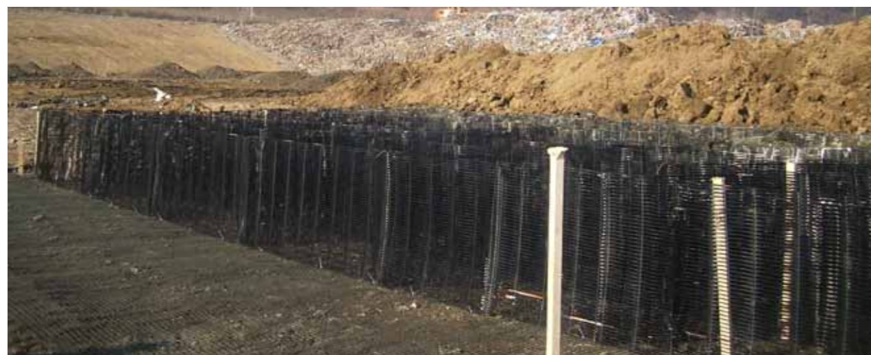
Aplicatie sistem TensarTech® Stratum® pentru construirea unui dig la depozitele de deseuri in condiții de teren foarte moale (Sighisoara, Romania).
