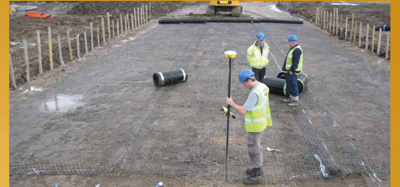
1. Baza sistemului este formată rapid prin derularea geogrilelor.
