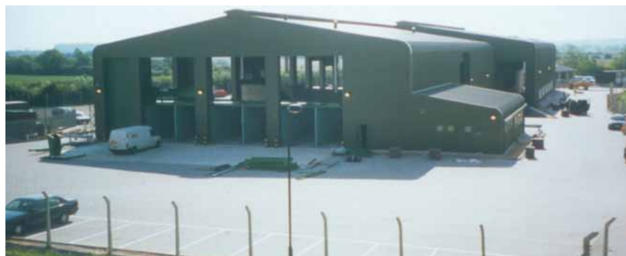
Aplicatie sistem TensarTech® Stratum® cu controlul tasarii diferențiate, cand se construiesc peste un depozit de deseuri (Elstow, Marea Britanie).
